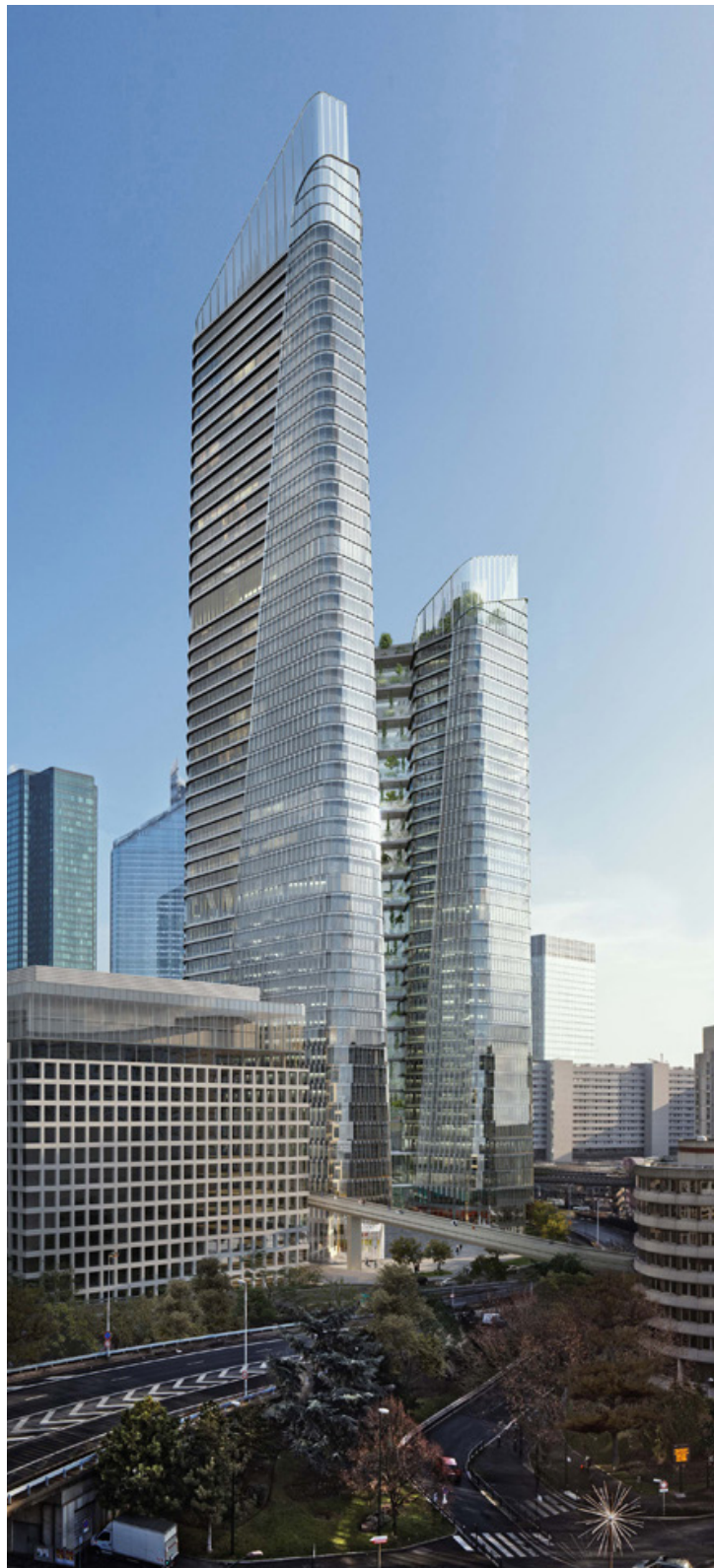
Vue du centre-ville de Puteaux. Les 2 ailes de la tour seront reliées par des «links», qui créeront des plateaux de 3000 m 2 en moyenne (6000 m 2 en duplex)
